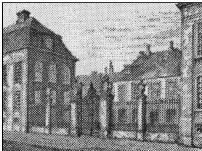
Frederiks Hospital - indgangen fra Bredgade.
